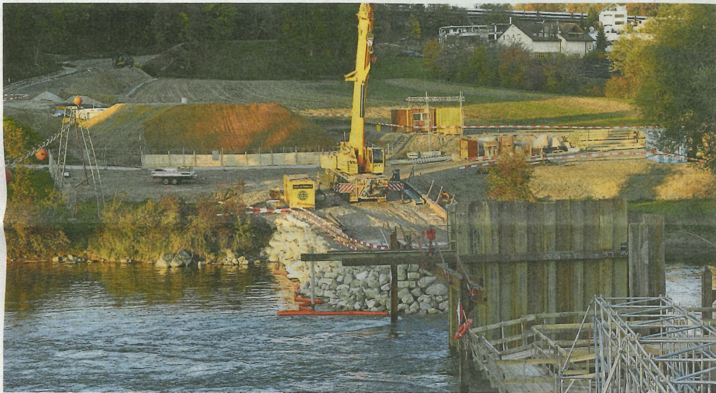
Eine neue Brücke über die Reuss ist das Kernstück für die Umfahrung von Mellingen.
