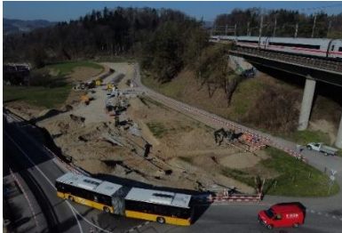
Auslöser: Bau Umfahrungsstrasse
